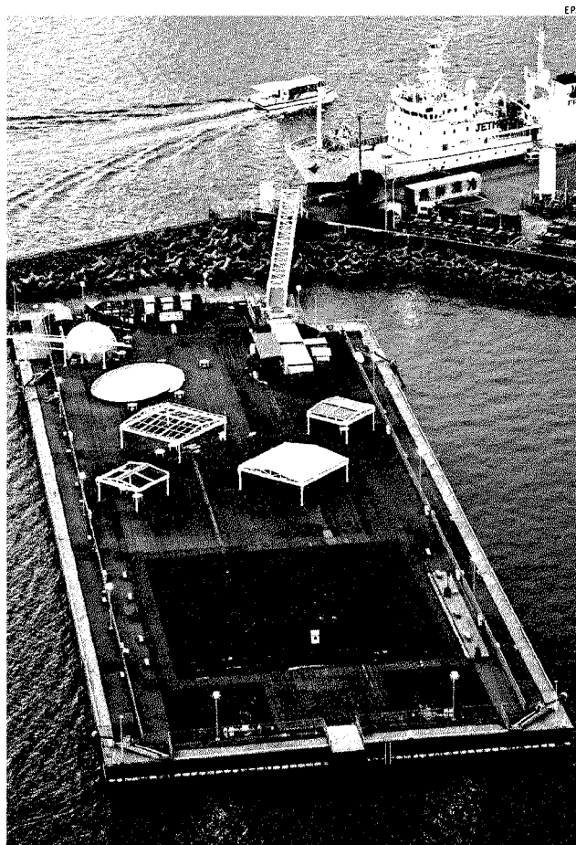
Piattaforma di salvataggio. Il serbatoio galleggiante che dovrà stoccare l'acqua altamente radioattiva della centrale di Fukushima
